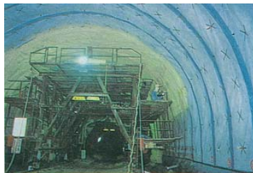
断熱材吹付け
