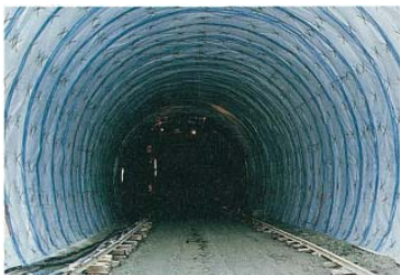
防水シート取付け
