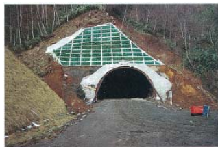
法面防護・捨砕施工後
