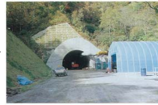
坑口部面壁施工後
